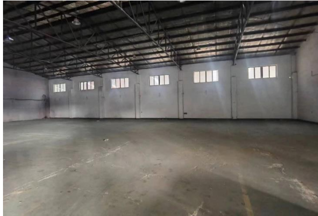
图 2-4 厂房内部现状照片
