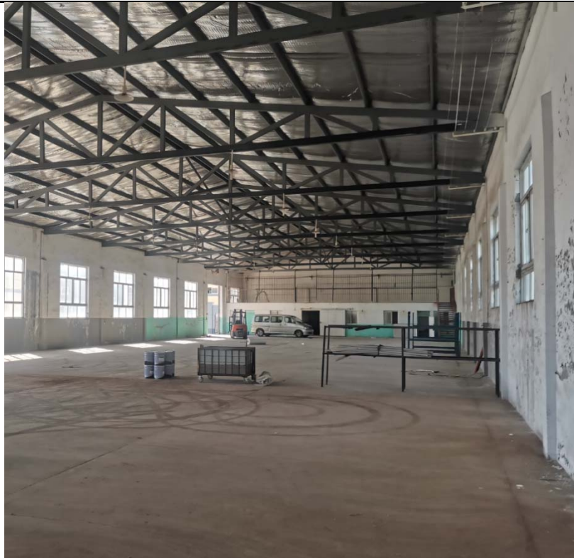
图 2-7 厂房内部现状照片
