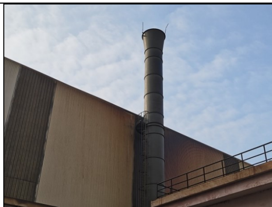
轧机乳化液油雾排气筒 (DA003)
