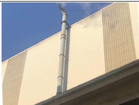
热镀锌脱脂废气排气筒 (DA016)
