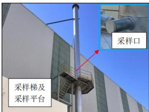
热镀铝锌退火炉排气筒 (DA018)
