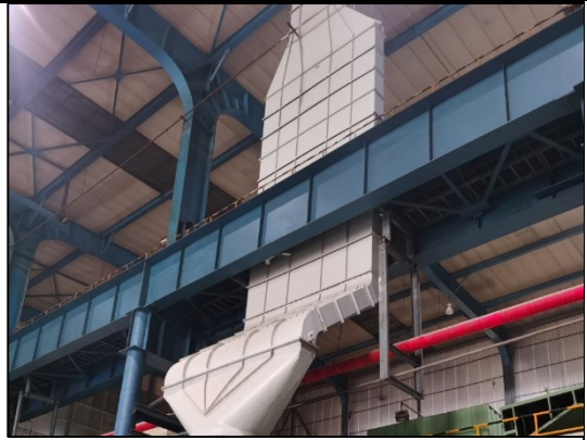
切割及平整粉尘排气筒 (DA008)
