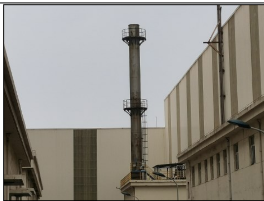
1#罩式退火炉烟气排气筒 (DA006)
