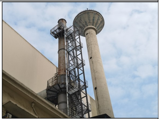
热镀锌退火炉烟气排气筒 (DA010)
