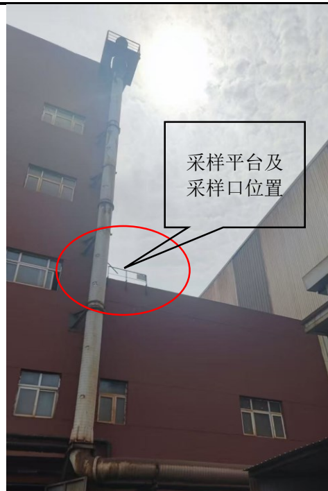
酸洗槽酸雾及漂洗烘干废气排气筒 (DA001)
