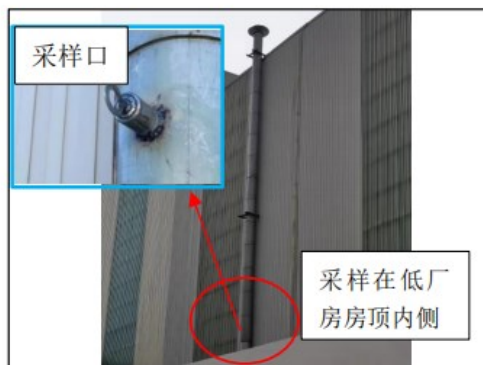
热镀铝锌脱脂废气排气筒 (DA017)
