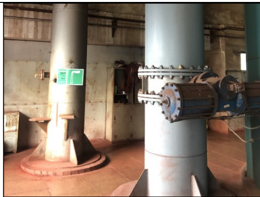
酸再生氧化铁粉尘收集装置废气排气筒 (DA005)
