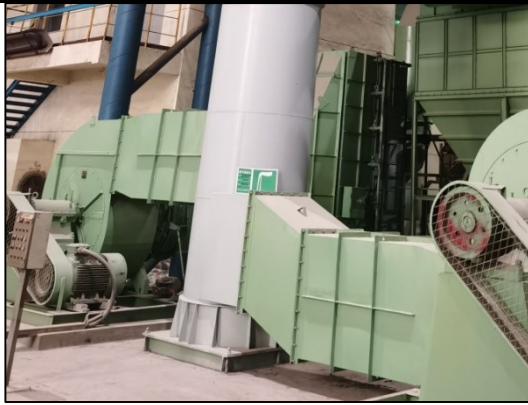
切割及平整粉尘排气筒 (DA008)
