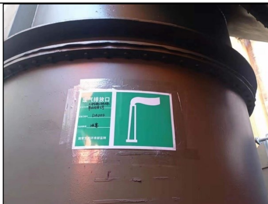
轧机乳化液油雾排气筒 (DA003)
