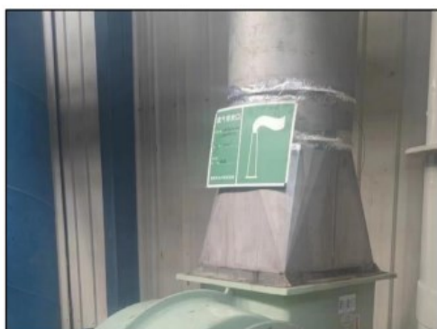
热镀铝锌脱脂废气排气筒 (DA017)
