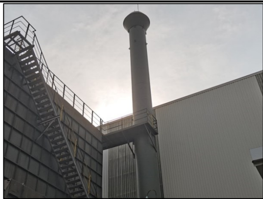
轧机工艺除尘废气排气筒 (DA004)
