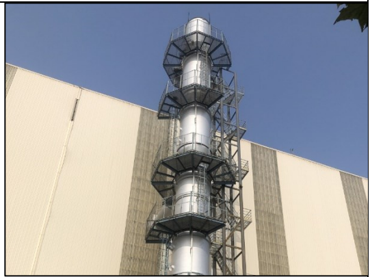
连退退火炉烟气排气筒 (DA009)
