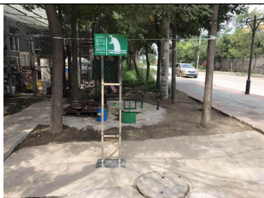
废水总排污口
