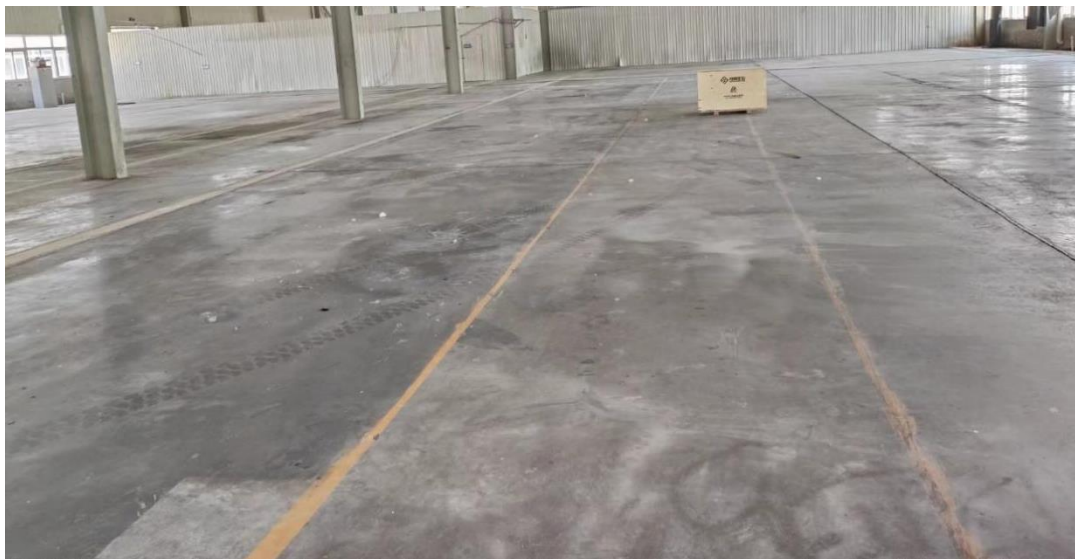
图 2-3 本项目所在厂房现状
