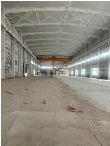
图 2-6 2 号厂房（注塑车间）现状照片
