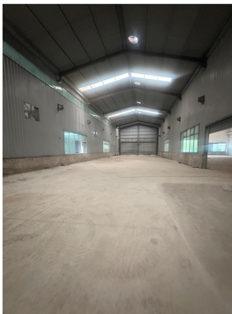
图 2-7 3 号厂房北侧部分区域（造粒车间）现状照片
