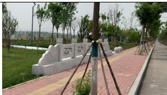
海沽道涵洞南侧
